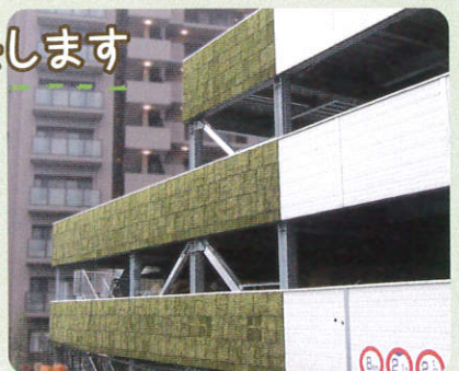
プレハブ立体駐車場壁面緑化の施工例
